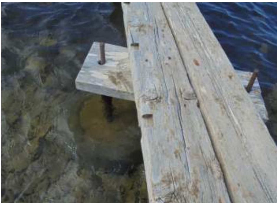
Figura 31. Sistema de fijación del pantalán número 4. Rueda rellena de hormigón con una varilla de hierro que sujeta el pantalán.
