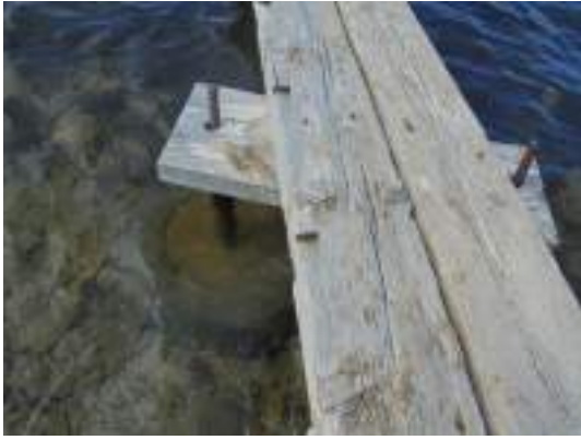
Soporte formado por rueda rellena de cemento con una varilla de hierro del pantalán número 4
