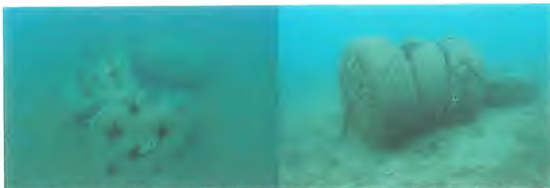
Fotografías 1.7. y 1.8.- Trenes de fondeo que consisten en un lastre ejecutado con ruedas, bidones, sacos, bloques de hormigón, etc.
