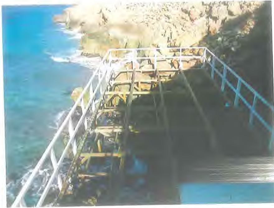
Fotografía 14. Estructura portante de la tarima II fuera de temporada
