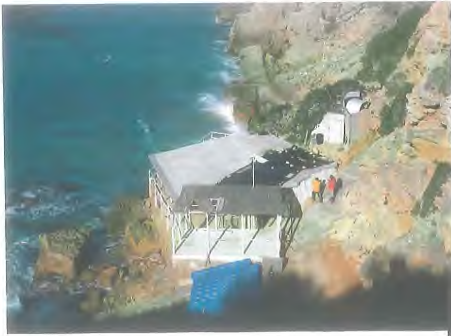
Fotografía 14. Foto general kiosco, caseta y rampa varadero.
