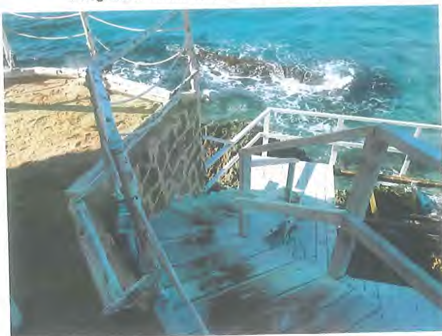
Fotografía 10. Escalera de acceso desde el kiosco hasta tarima II
