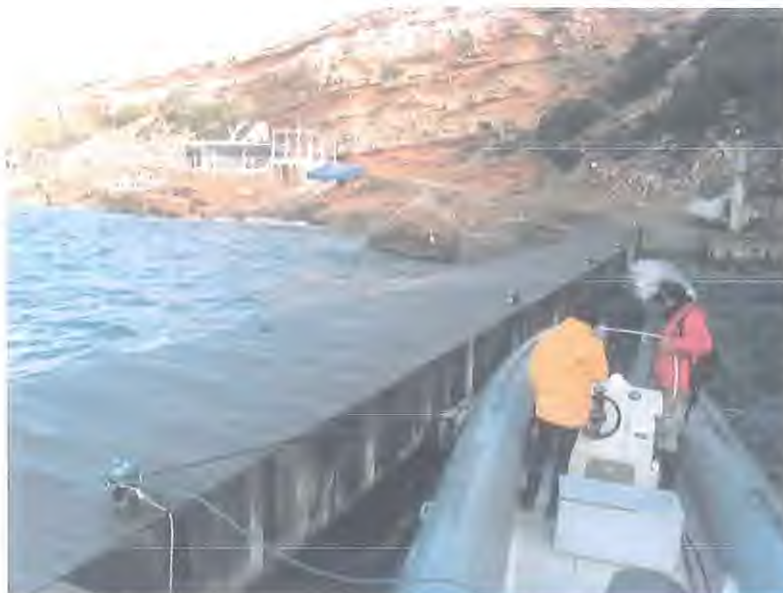
Fotografía 5. Vista general de las instalaciones terrestres en cala es Blancar.
