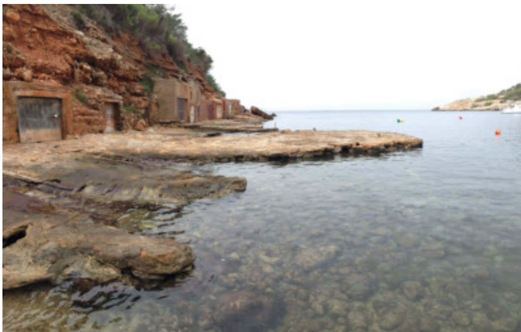
Fotografía 2. Vista actual del embarcadero desde una de las casetas varadero cercana. Presenta un estado de conservación aceptable.
