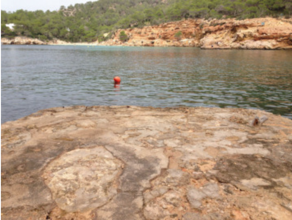
Fotografía 5. Vista del cantil del embarcadero existente donde se aprecian los bolardos de madera embebidos en el hormigón vertido en la superficie del mismo.
