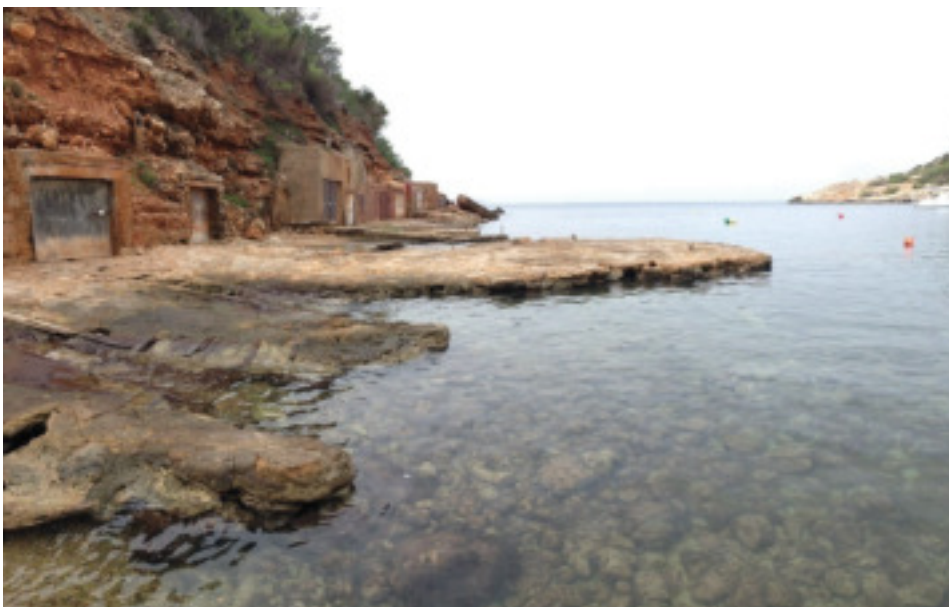
Fotografía 2. Ligeros descalces existentes bajo el embarcadero debido al movimiento de los bloques de escollera a causa del oleaje. Fuente: Propia.
