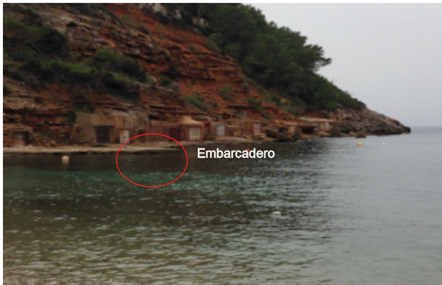
Fotografía 1. Vista general del margen izquierdo de cala Salada, donde se aprecian las casetas varadero existentes y el canal de navegación.
