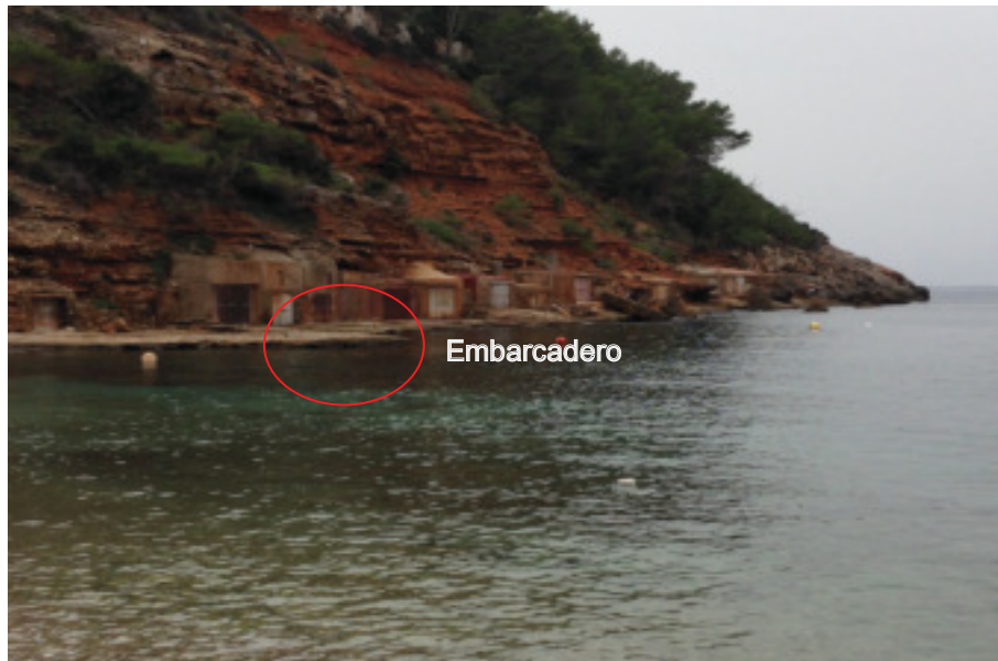
Fotografía 1. Vista general del margen izquierdo de cala Salada, donde se aprecian las casetas varadero existentes y el canal de navegación. Fuente: Propia.
