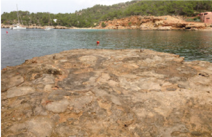
Fotografía 3. Plataforma actual del embarcadero. Se aprecia una superficie irregular con bolardos de madera para el amarre de las pequeñas embarcaciones que actualmente hacen uso del embarcadero.
