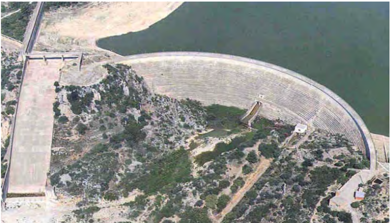
Figura VI.4. Presa de María Cristina en la Rambla de la Viuda, de tipo gravedad.
