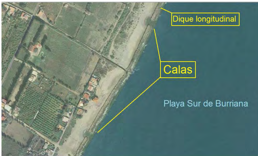
Figura 6.26: Calas en la playa Sur de Burriana formadas por la abertura de un hueco en el dique longitudinal (foto: DGSCyM)
