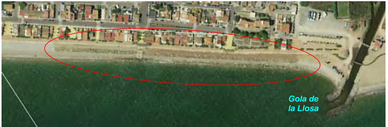
Figura 2.24 Escollera en Barri Mar.
