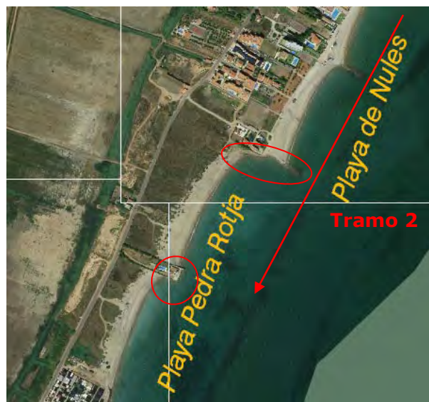
Figura 2.17 Escolleras en la playa de Pedra Rotja.
