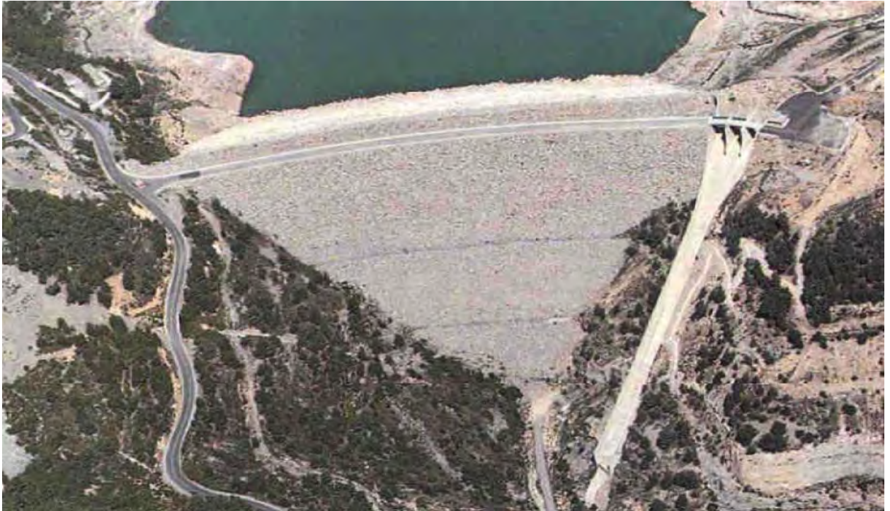
Figura VI.2. Presa de Arenós en el río Mijares.
