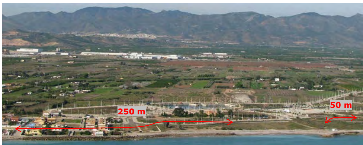
Figura 2.19 Escolleras en la Playa de La Torre.
