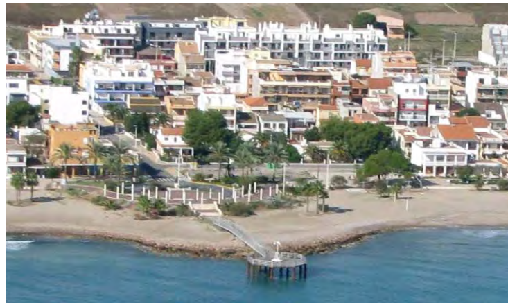
Figura 2.21 Escollera y mirador pilotado en Chilches.
