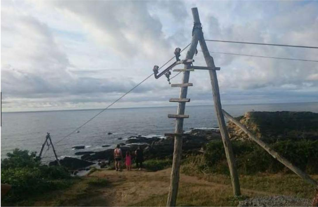
En este soporte (nº 3) se ve el cable guía, el maquinillo, o carro, que se desliza sobre el cable guía, y el cable tractor enganchado al maquinillo.
