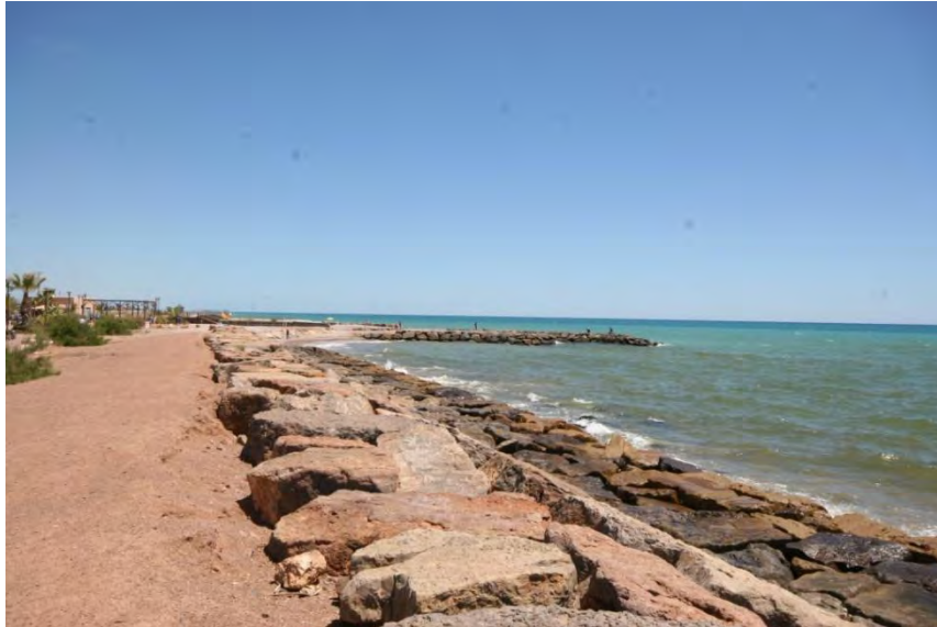
Vista de la defensa de escollera y gola de la Llosa
