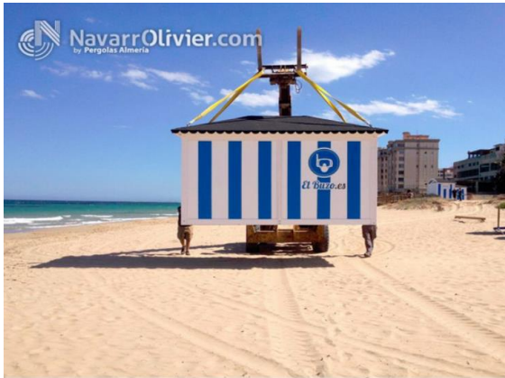
Figura 6: Montaje módulo prefabricado
