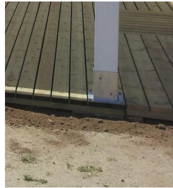
Figura 4: Modelo de pérgola playa y detalle del anclaje mediante soporte metálico. Fuente: www.modulexter.com
