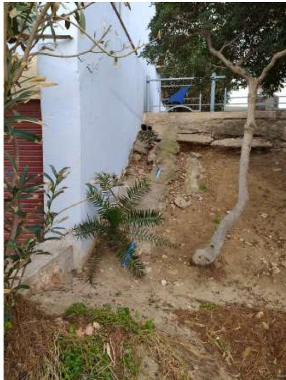
Detalle del talud junto al restaurante "El Náutico" en donde se puede ver como existe una conducción adosada a la construcción.
