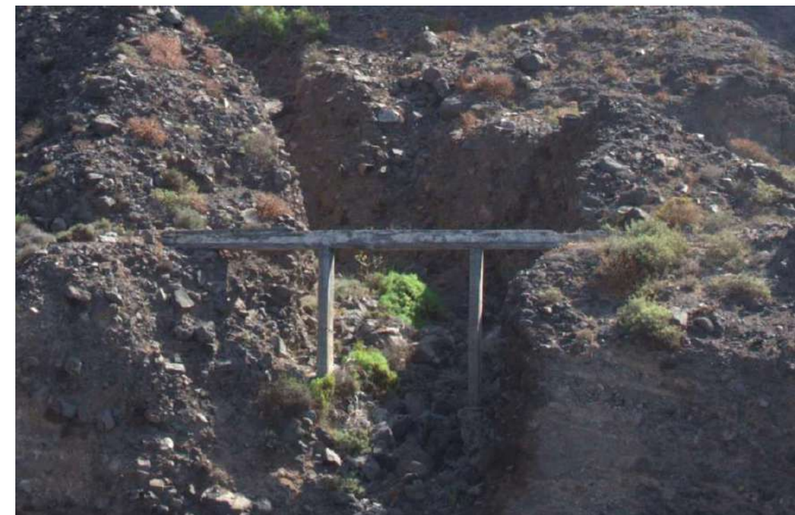
Figura 3. Tramo de acueducto
