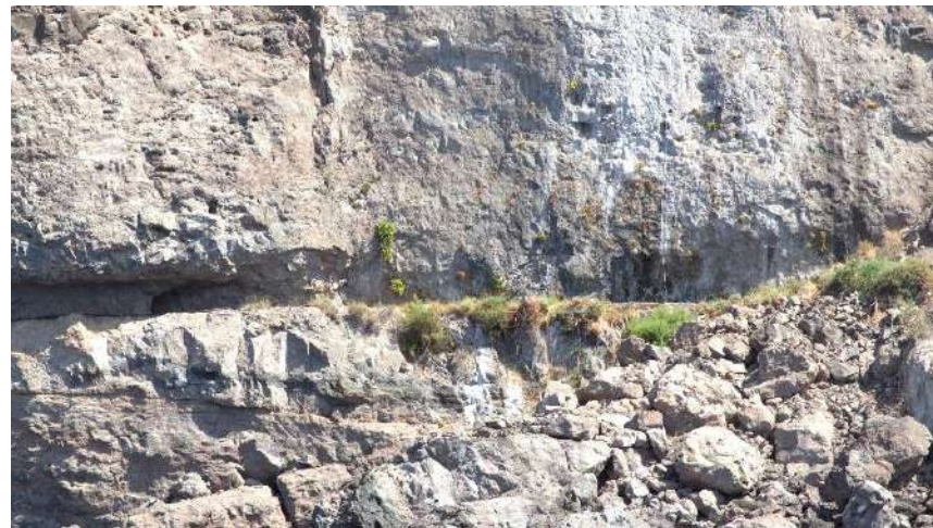
Figura 4. Mal estado de conservación (abundancia de vegetación próxima al canal). Fuente: Elaboración propia
