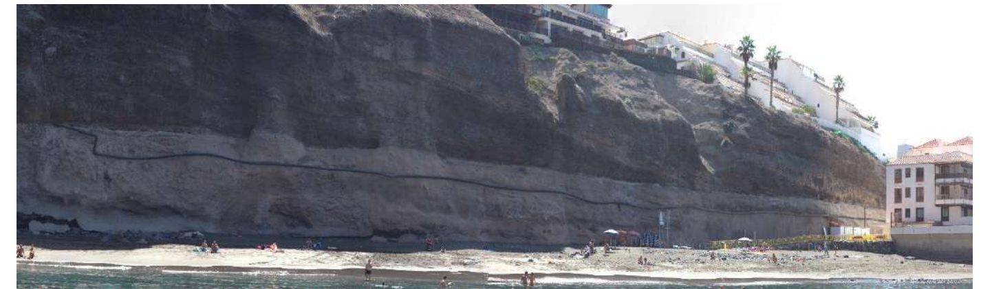
Figura 2. Tramo de tubería colocado superficialmente
