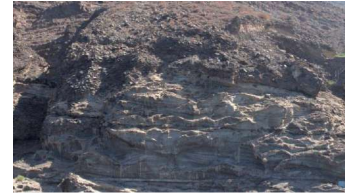
Figura 13. Evidencia de riesgo por desprendimiento. Fuente: Elaboración propia
