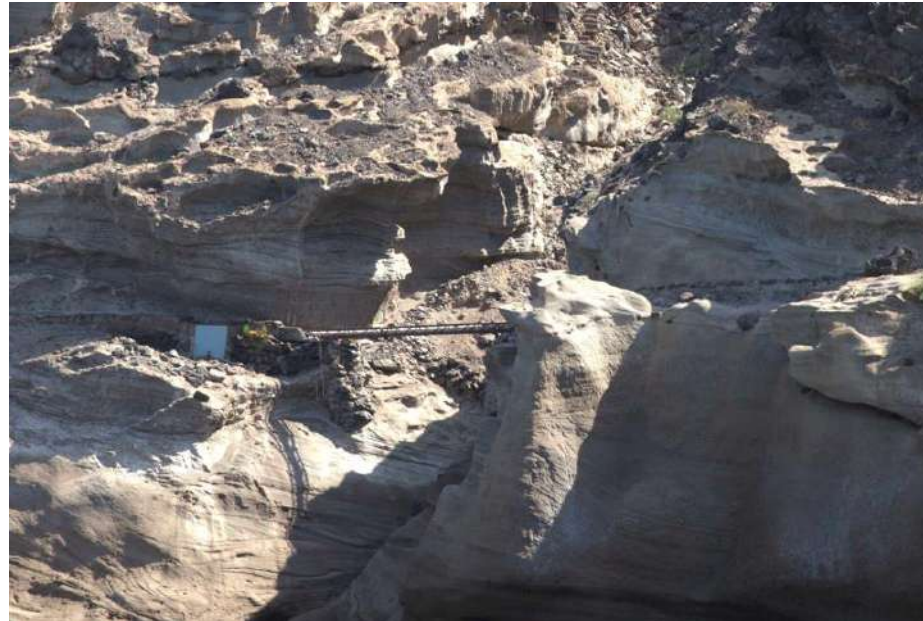
Figura 4. Tramo de acueducto volado
