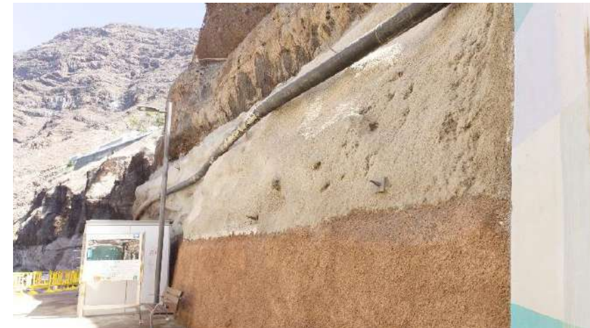
Figura 27. Comienzo del Tramo 8. Fuente: Elaboración propia
