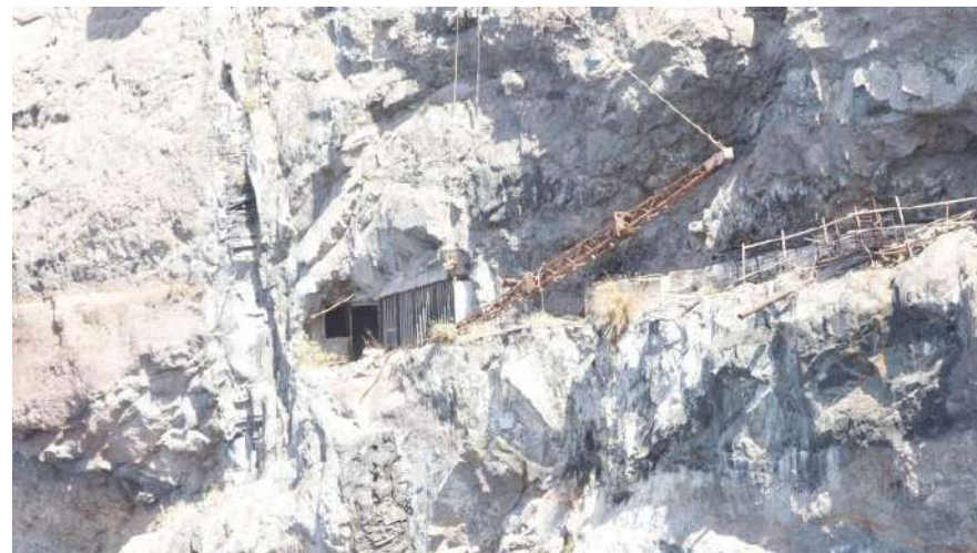
Figura 5. Bocamina del canal. Fuente: Elaboración propia
