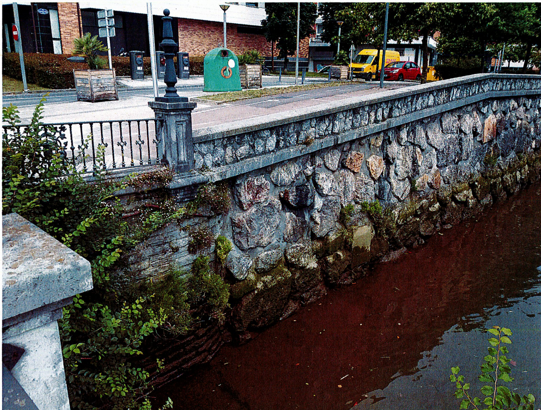
Fotografía del muro de ribera en el límite del cauce
