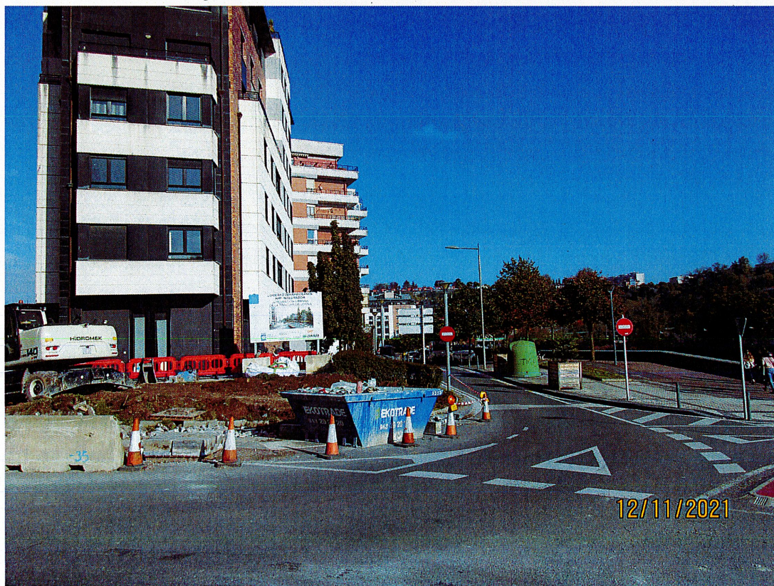
Fotografía del paseo dentro del dominio público marítimo-terrestre y del entorno
