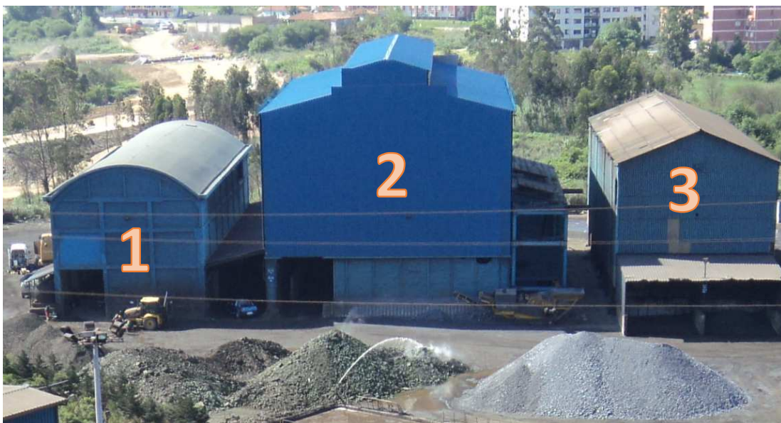
Vista Norte de las naves existentes
