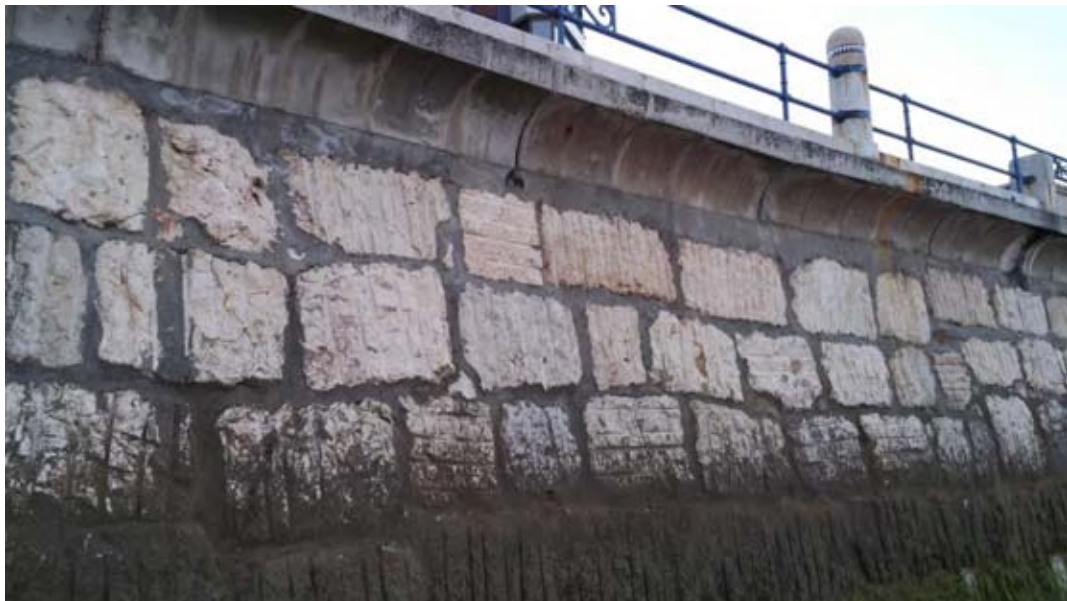
Imagen 6: Vista detalle del muro
