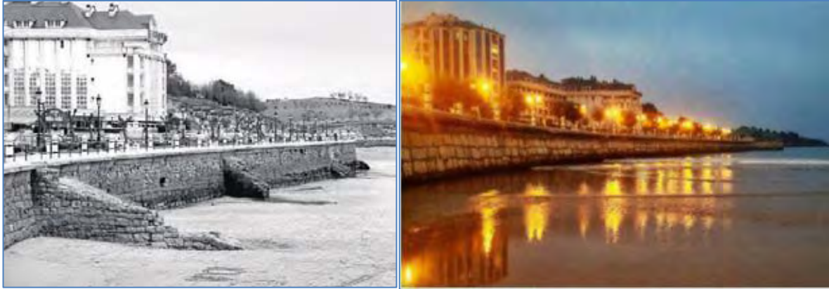
Imagen 3: Comparativa del muro con y sin espigones (Playa II de El Sardinero)
