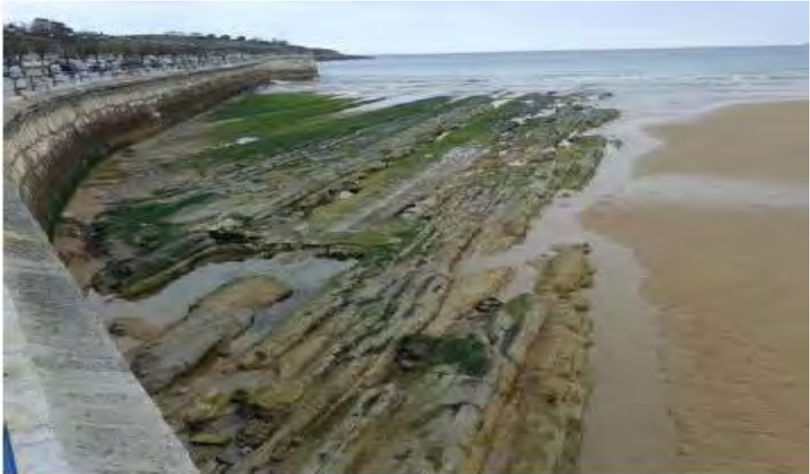
Ilustración 5: Erosión producida en la zona
