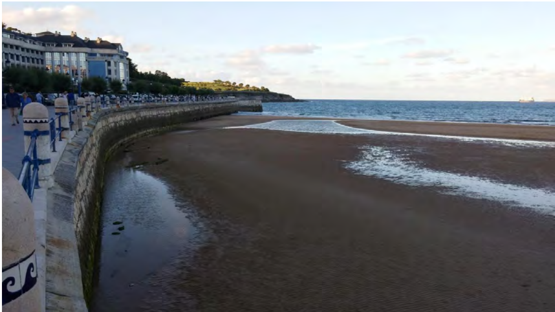
Imagen 3: Vista de la zona de actuación avanzando desde el extremo sur
