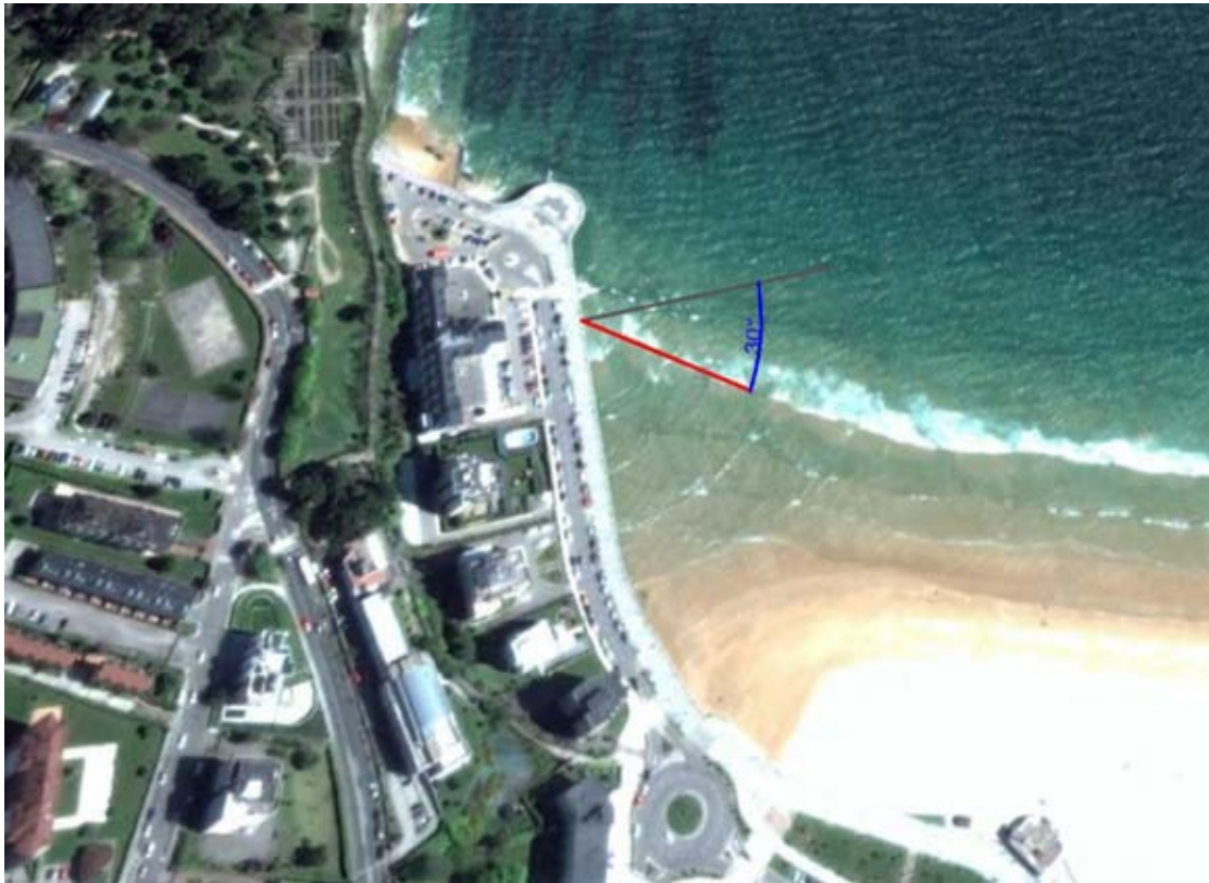
Ilustración 3: Incidencia del oleaje en el muro. Fuente: Google Earth
