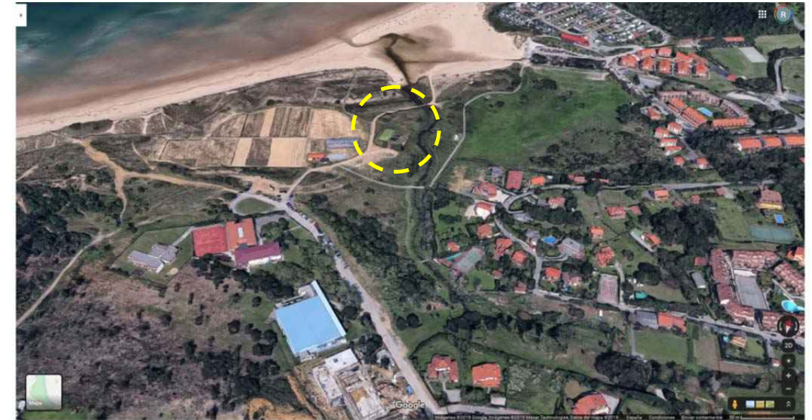
Ámbito de actuación: EDAR de Loredo
