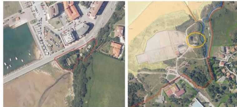
ÁMBITO 1. Instalaciones en SOMO
