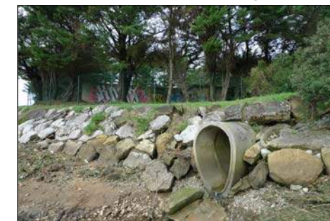
foto 8. Escollera y conducción de desagüe
