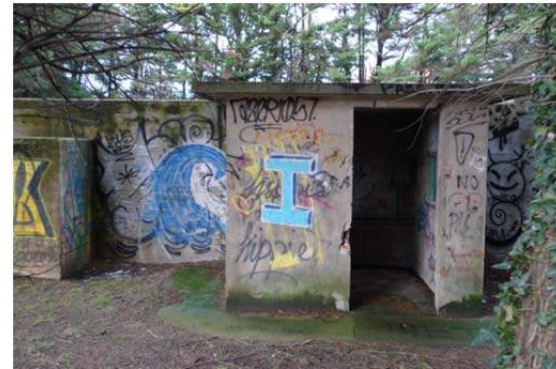
Caseta de control
