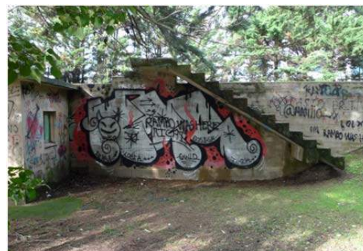
Escalera de acceso a la pasarela
