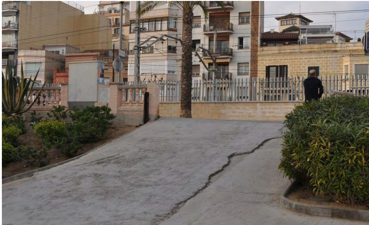
Fotografía 10.- Rampa de acceso a la playa de Ocata junto al puerto deportivo de El Masnou (Fuente: elaboración propia)
