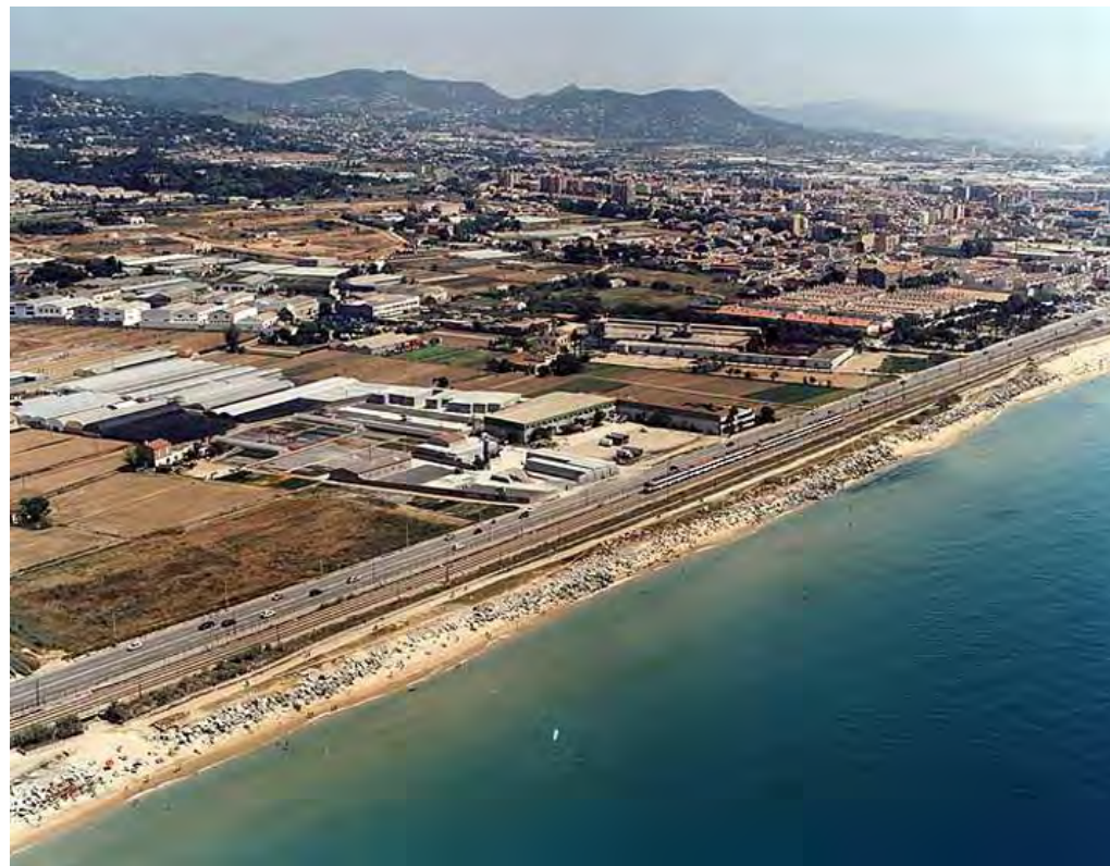
Fotografía 22.- Escollera entre las playas de Ocata y Ponent (Fuente: antigua Dirección Gral. de Costas)
