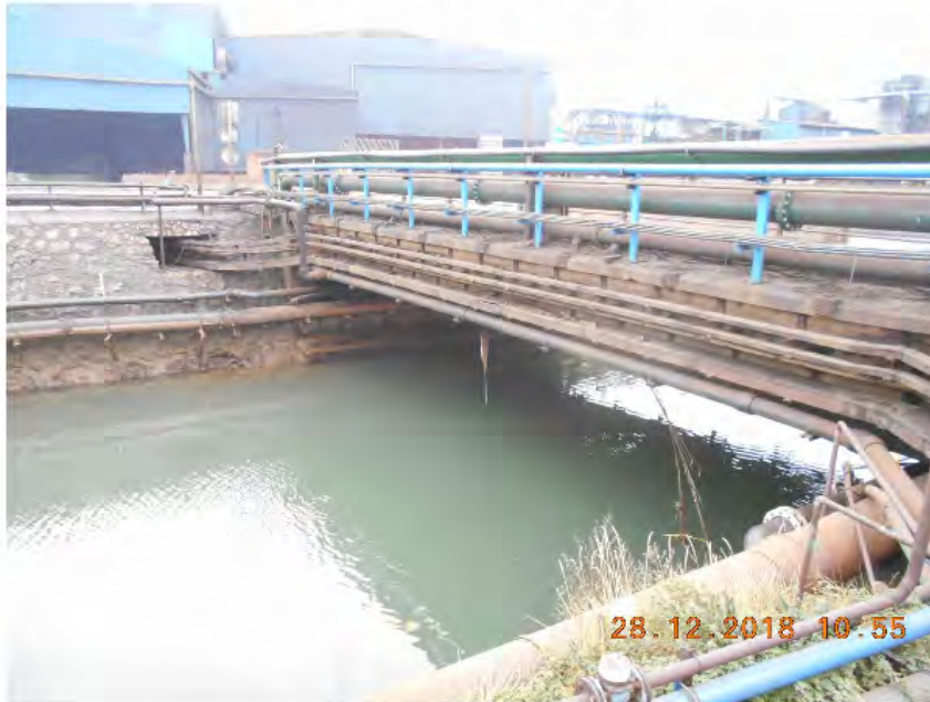
FOTO 2: PUENTE LADO NORTE DESDE ASTILLERO
