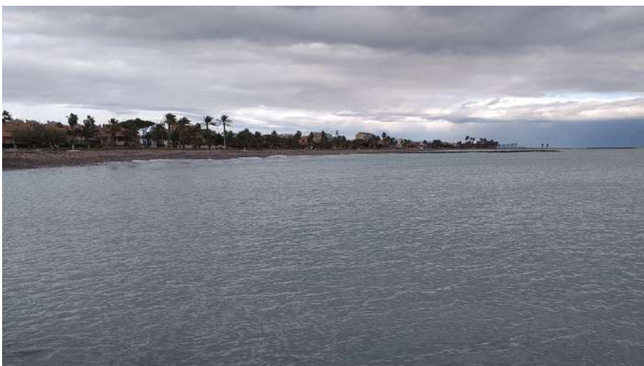
Vista del litoral, entre el primer y segundo espigón.
