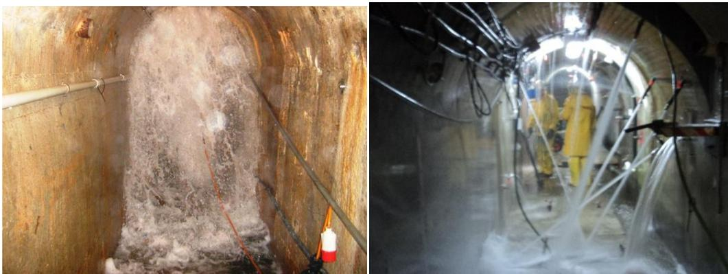
**Ilustración 2: Ejemplos de grandes filtraciones tratadas con éxito en presas mediante esta tecnología.**
