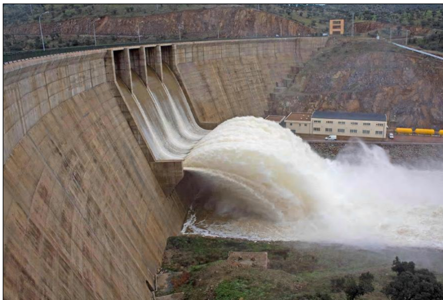
Ilustración 2: Evacuación de una avenida por el aliviadero de una presa. Las normas de explotación incluyen los procedimientos a aplicar en situaciones extraordinarias como ésta.
